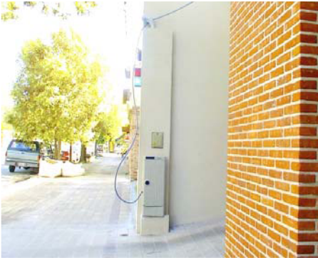
VISTA DE UNA PARED PARA FIJACIÓN DE LA CAJA DISPLAY Y CONECTOR PARA CORTE
